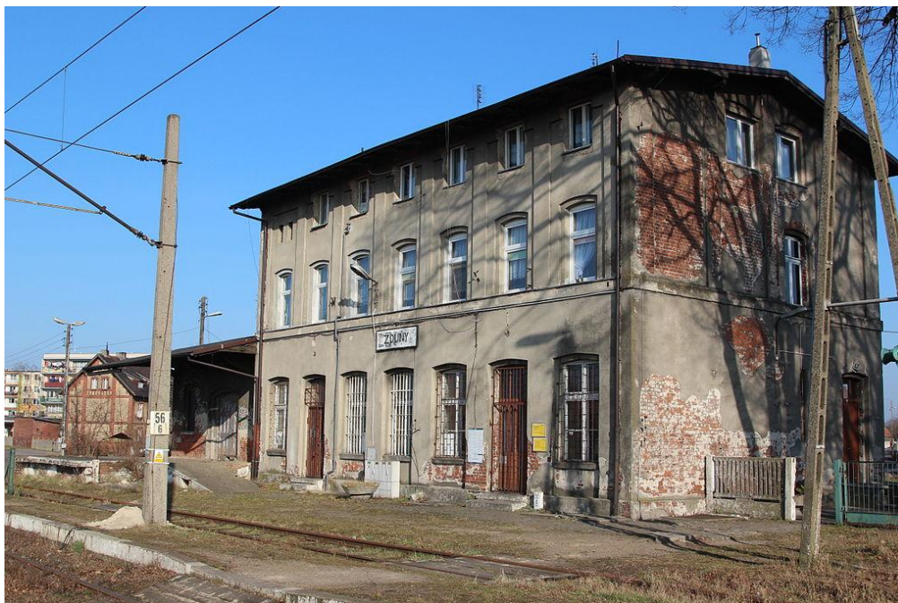
Fotografia 7 Stacja kolejowa w Zdunach
